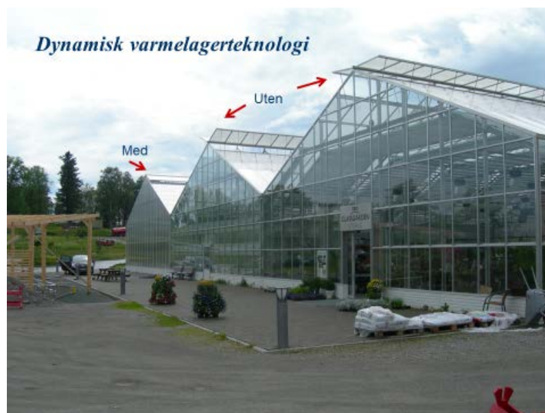
Figur 1. Bilde fra Mære landbruksskole som illustrerer forskjellen i behov for utlufting ved bruk av takluker mellom veksthus der varmepumpeteknologien er tatt i bruk i forhold til andre veksthus.
