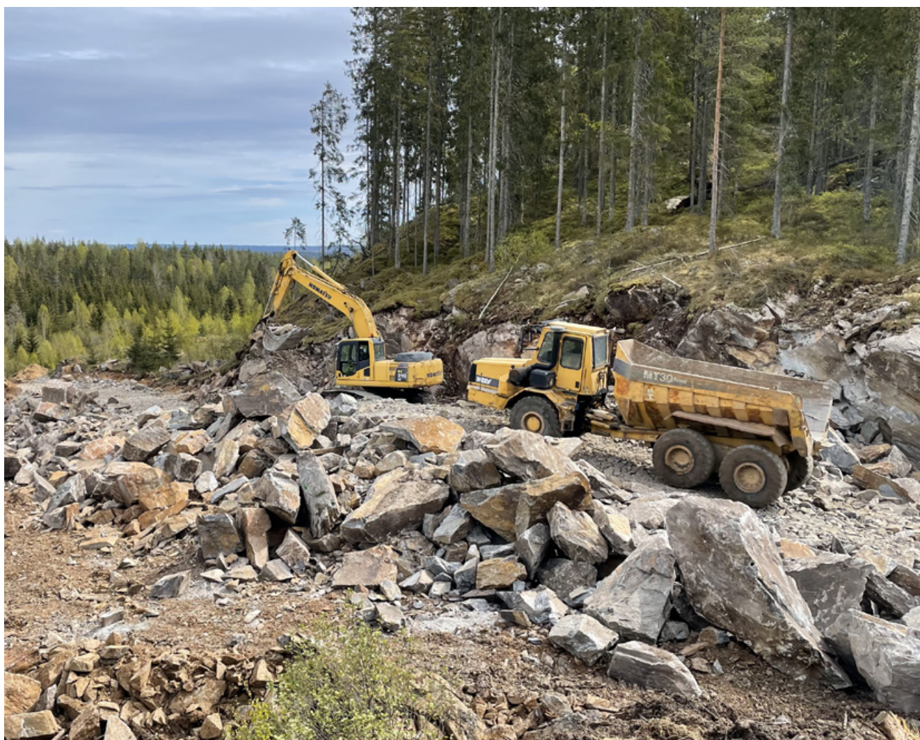
Figur V7.3. Sprengte masser sorteres og kjøres ut på veianlegget. Foto: Martin Bråthen, Skogkurs.
